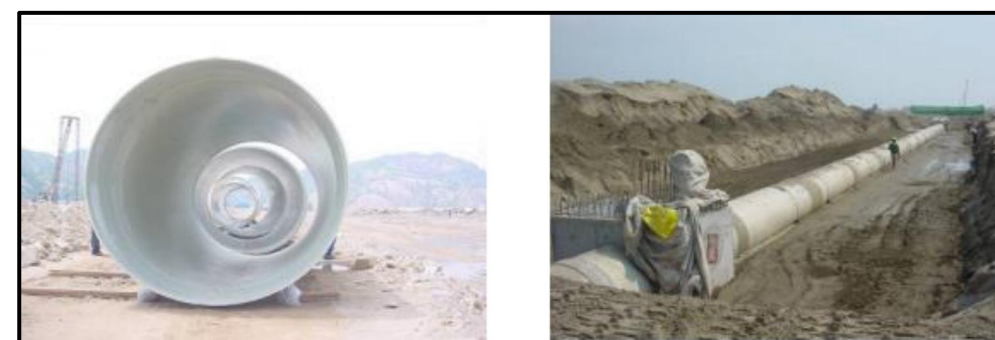
图5-5 玻璃钢夹砂管使用实例
