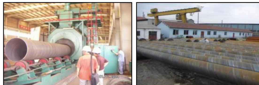
图5-1 钢管工厂化加工表面除锈后钢管
