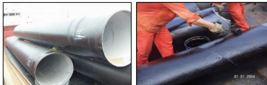
图5-2 钢管防腐处理
