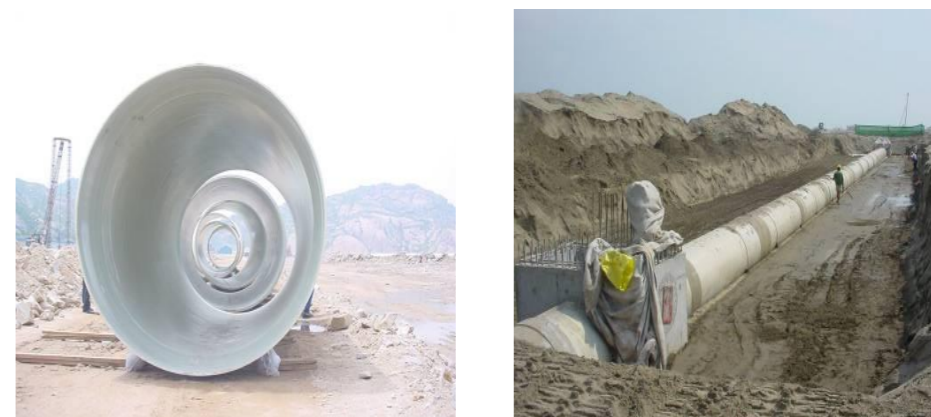
玻璃钢夹砂管使用实例
