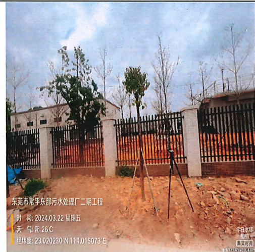
厂界东南侧外 1 米处
