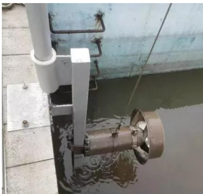
图4.2-1 潜水搅拌器安装示意图
