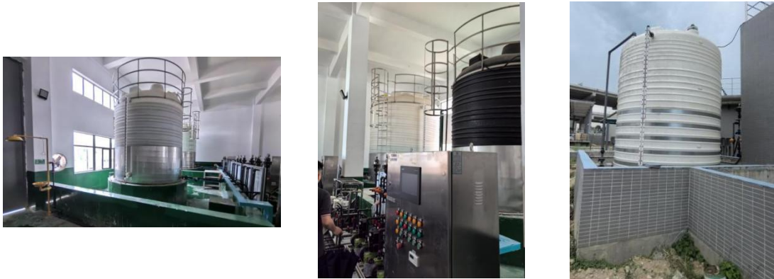
图 5.2-1 储罐及围堰
