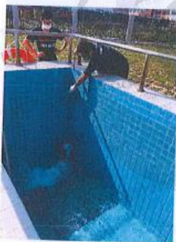
一期提标工程污水排放口
