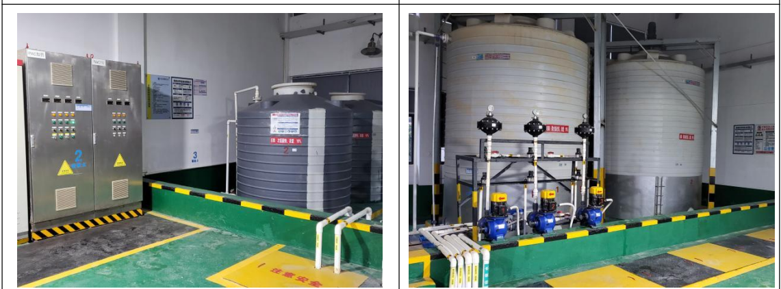
化学品储存区
