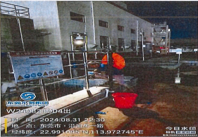
本期工程出水口
