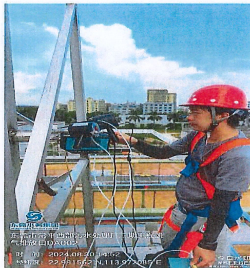
有组织废气排放口DA002
