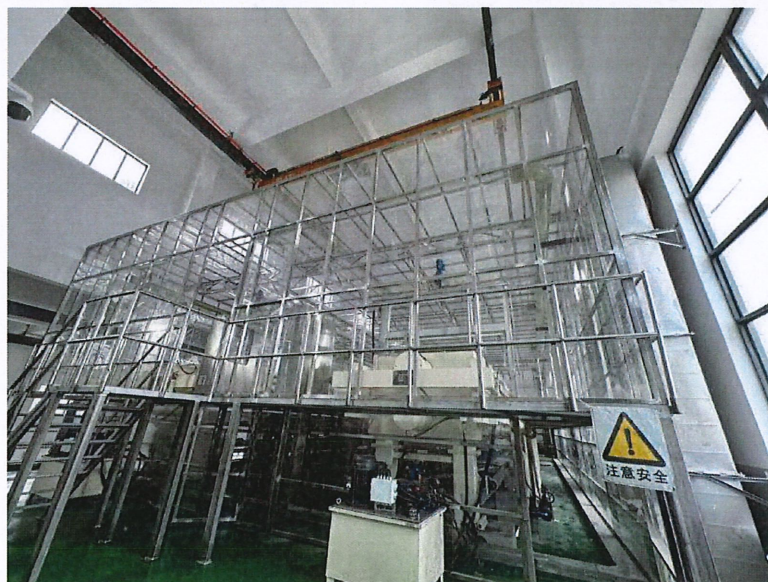
污泥脱水车间
