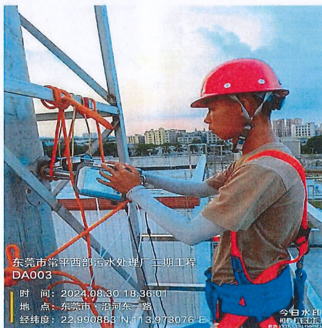
有组织废气排放口DA003
