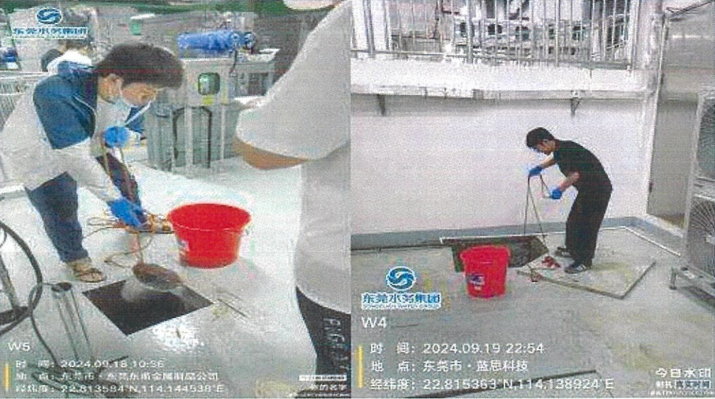
本期工程进水口
