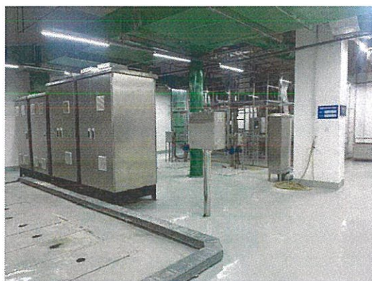
粗格栅及进水泵房
