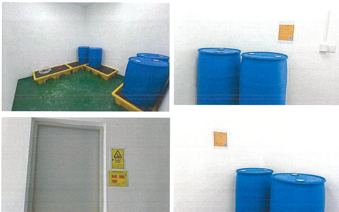
厂区实验室危废仓标识、分类存放配备托盘应急物资
