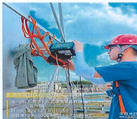
有组织废气排放口DA002
