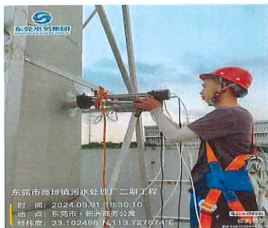
恶臭废气1#排放口
