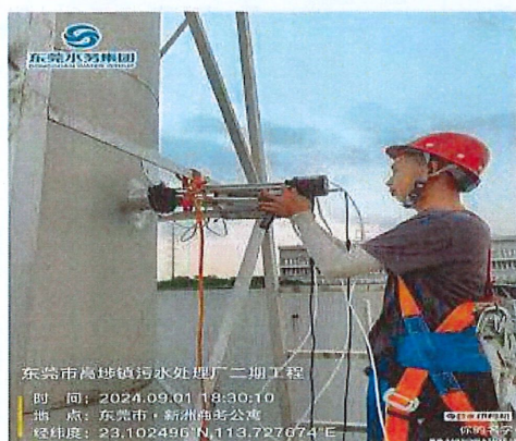
有组织废气排放口DA001
