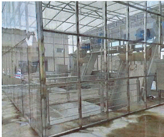
粗格栅及进水泵房
