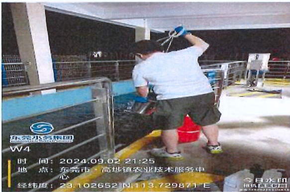
本期工程出水口
