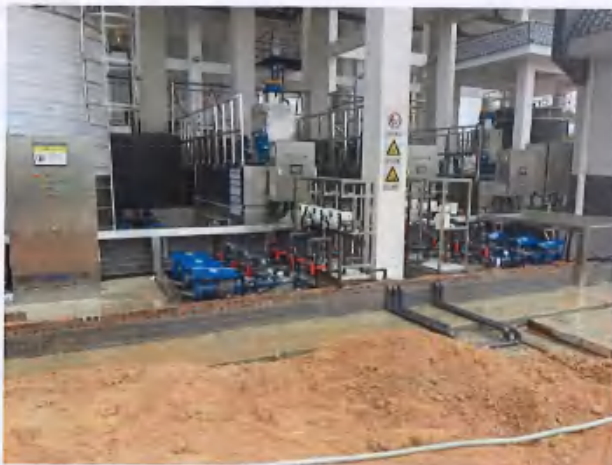
储罐设有围堰，有效防止泄漏
