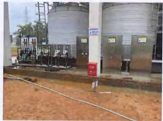
储罐设有围堰，有效防止泄漏
