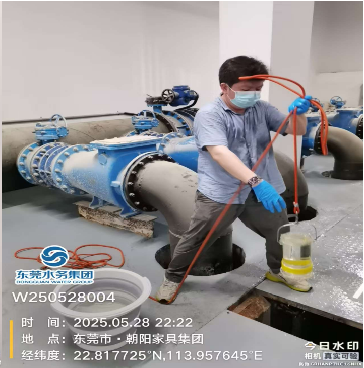
本期工程出水口
